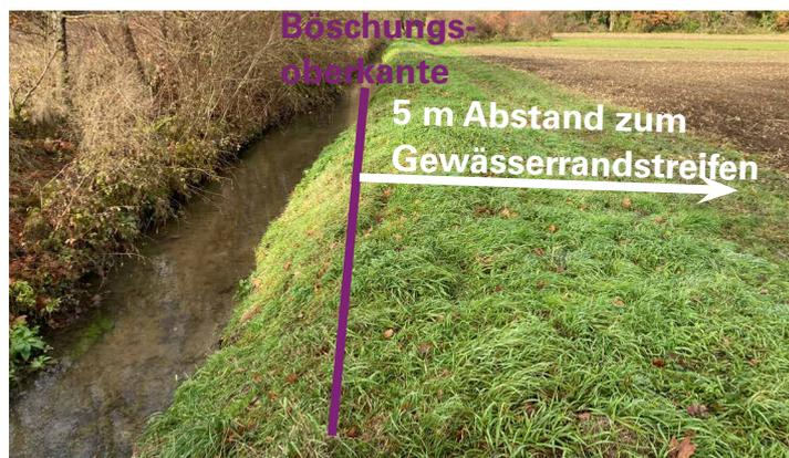
Feststellung des 5 m Bereiches zur Böschungsoberkante
